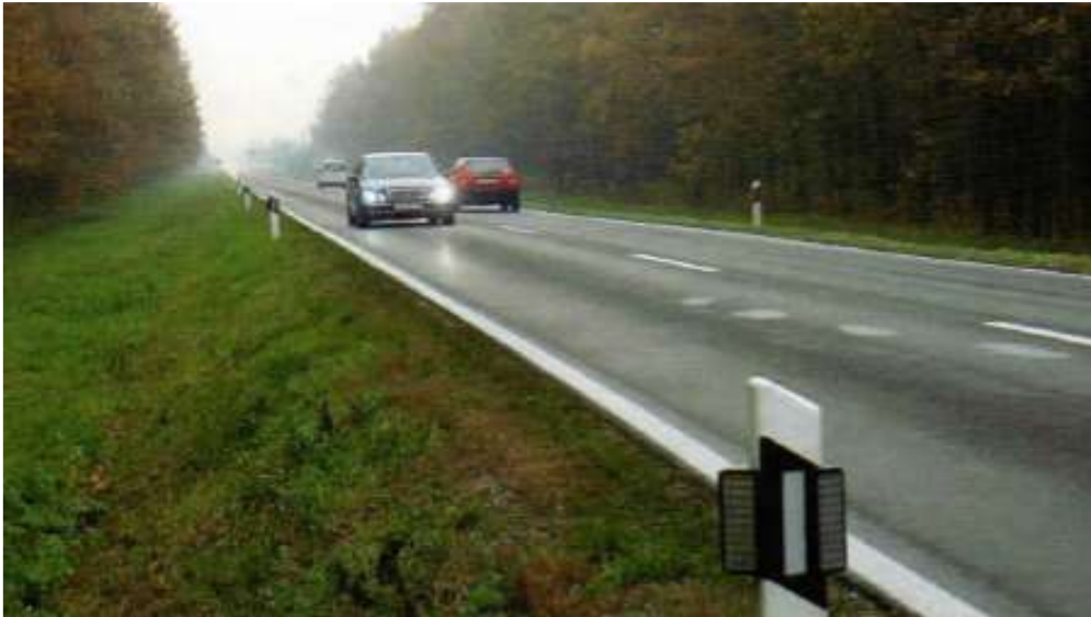
Слика 56. Оптички рефлектори на стубићима
