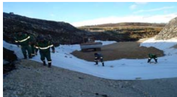
Slika 4. Izgradnja drenažnog sistema za prikupljanje procjednih voda
